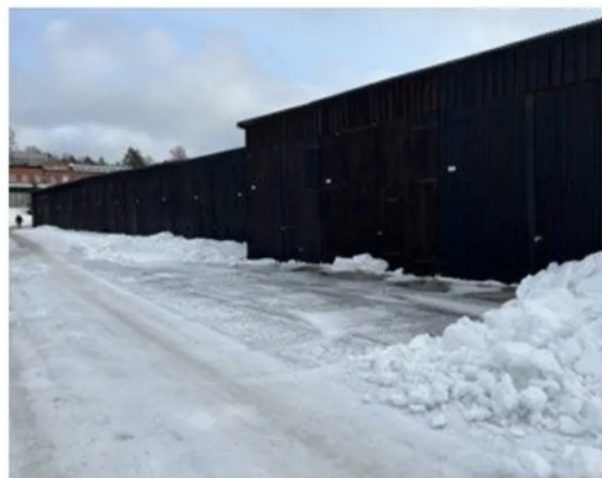
Det här är en av flera längor med båthus som kommunen vill få bort senast till 30 augusti 2025 plus betongbryggorna i vattnet med mera.
